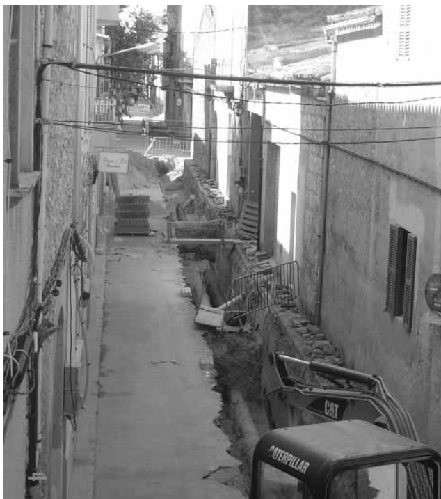
Obras de pluviales en calle Asalto
