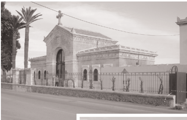
Accés lateral i reforma integral del tanatori, per a la millora dels serveis funeraris
