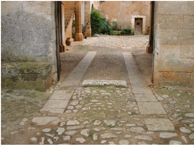
Paviment del portal d'accés
