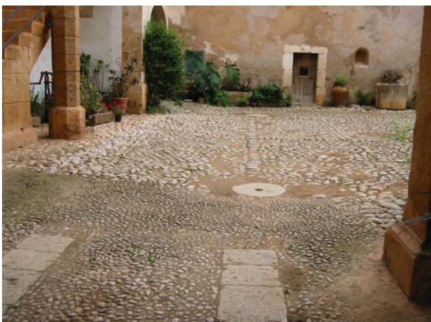
Paviment de la claustra amb la boca de recollida de les aigües pluvials
