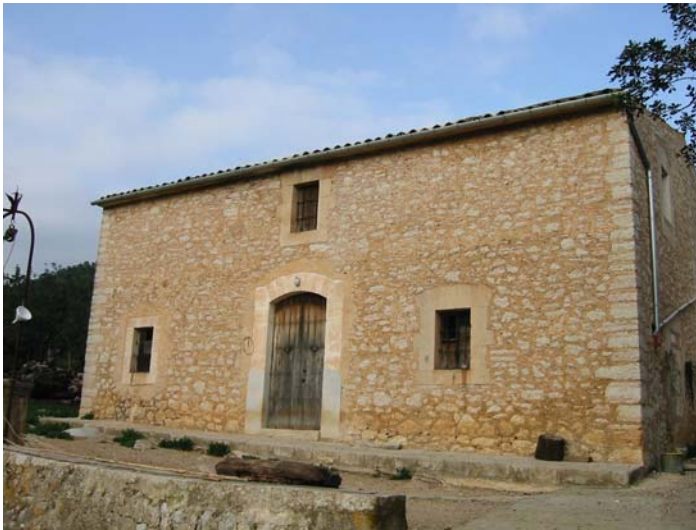
Façana principal de la casa nova
