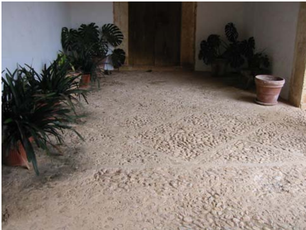
Paviment interior del portal d'entrada
